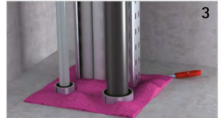
Falls gewünscht, überschüssigen Schaum abschneiden.
