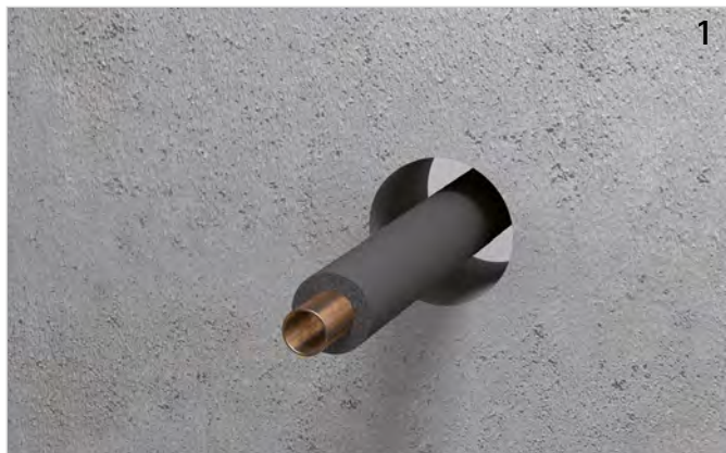
Rohrleitung mit Dämmung installieren.
