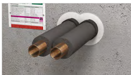
Nullabstand in Massivbauteilen
