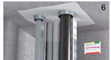
Kennzeichnungsschild ausfüllen und neben der Abschottung anbringen.
