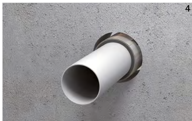
4 Manschette in die Bauteilöffnung schieben (Überstände beachten).
