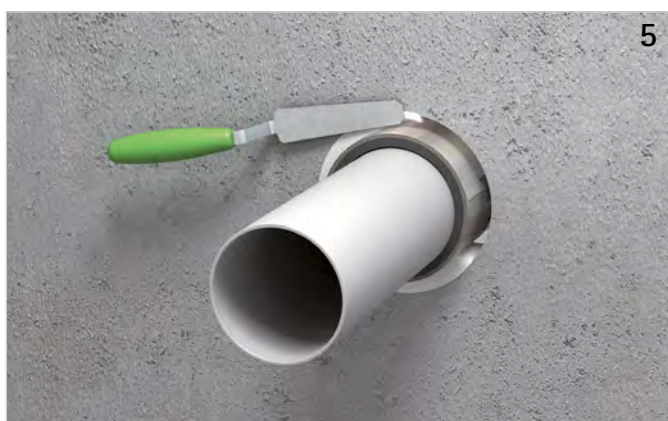
5 Restspalt rauchgasdicht (mit Tangit FP 550 oder Walraven Pacifyre® FPM Brandschutzmörtel) verschließen.
