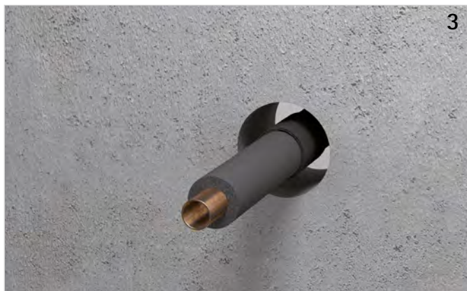
Rohrummantelung in die Bauteilöffnung schieben (Überstände beachten).
