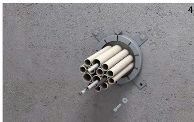
4 Die ausgewählte Manschette montieren.
