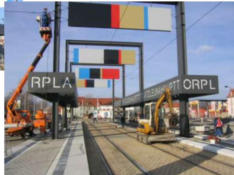
Leuna komplette Straßenbahnhaltestelle als „Pergola“ Werkstattplanung, Ausführung komplett ab OK. Fundament
