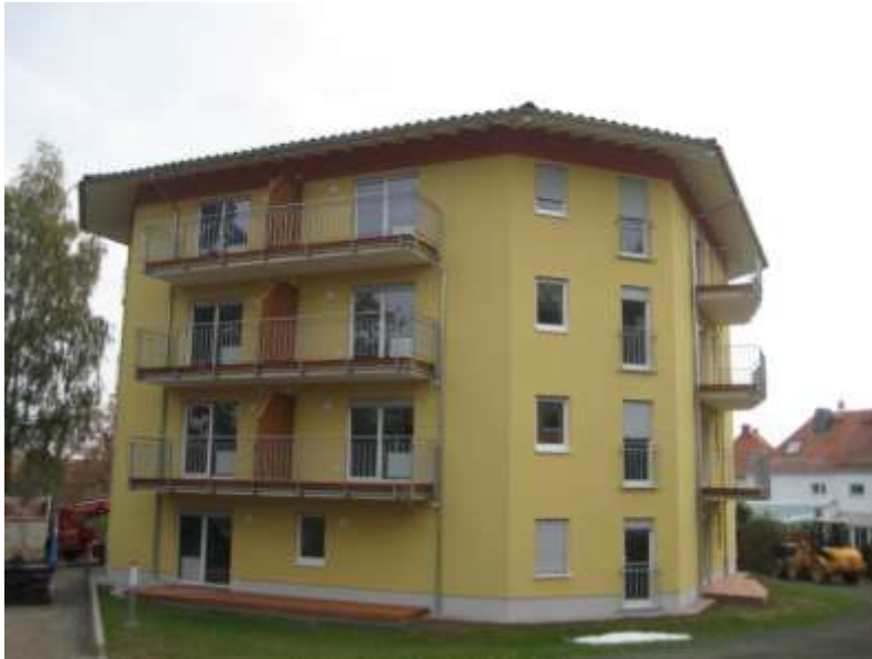
Krankenhaus Freiberg, 2 Wohn-Blocks Glasfassaden, Geländer Planung und Ausführung
