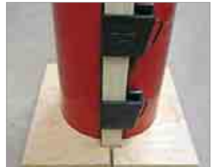
Tubbox® Multi Spezial-Rundstützenschalung mit Fixierung der Säulenschalung
