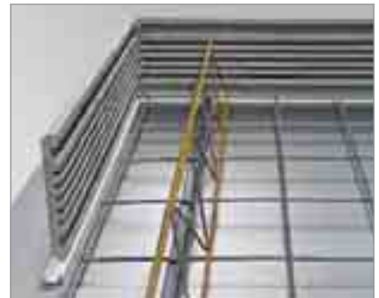
Aufkantung aus Faserbeton
