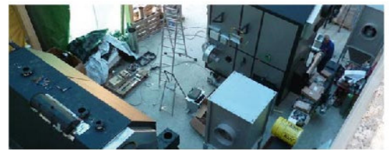
Bau der Hackschnitzelanlage
