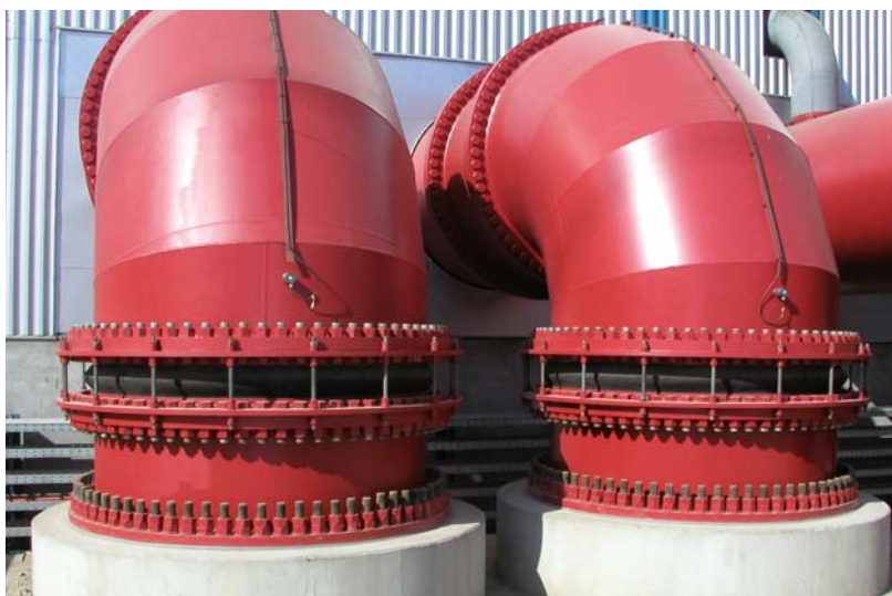
Großkompensatoren mit Verspannung im Kraftwerkseinsatz Large expansion joints with limiters for power stations
