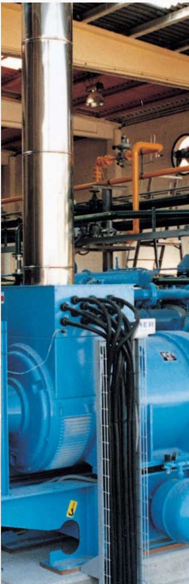
Aggregatelagerung auf SYLOMER® Plant bedding on SYLOMER®
