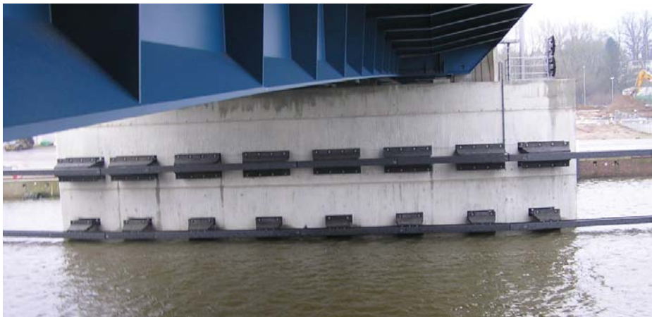
Fendersystem als Leitwerk einer Wasserstraße Fender system to protect both sides of a canal bridge
