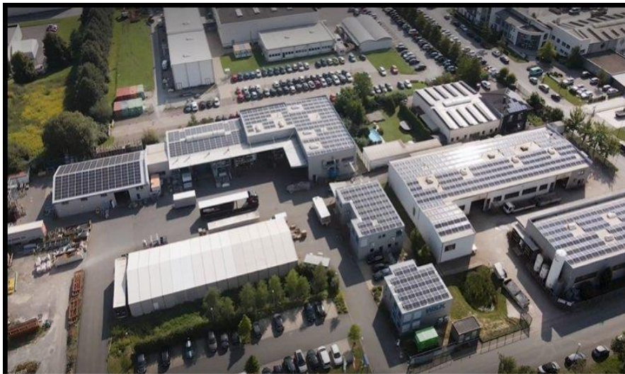
Produktionsstandort Lippstadt – über 5.000 m 2 Fertigungsfläche
