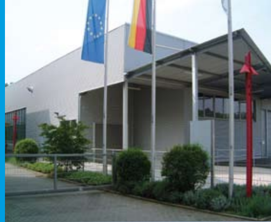
Werk 1 / Factory 1 Oberer Wasen 14 73630 Remshalden
