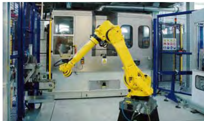
- ISOLA DI TEMPRA - INDUCTION TEMPERING CELL
