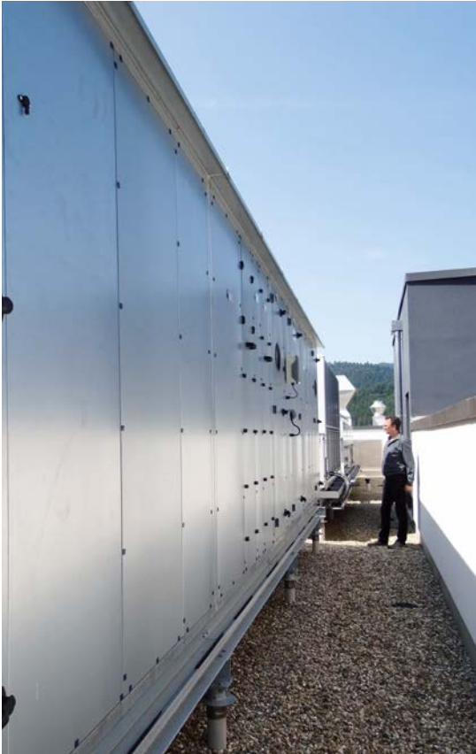
Jörg Schreiber, hier auf dem Firmendach mit der Belüftungsanlage, ist stolz darauf, seinen Standort ohne fossile Brennstoffe betreiben zu können.
