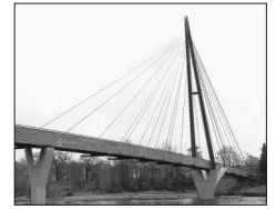
Brücke Cracauer Wehr, Pylonabspannung
