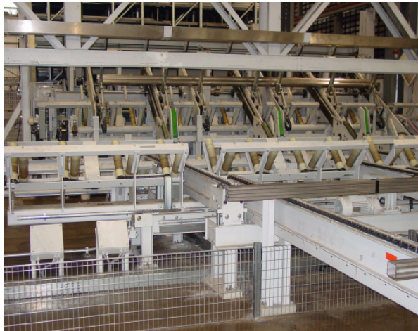
Kettenförderer , heb – und senkbare V – Rollenbahn Im Hintergrund Bundformer
