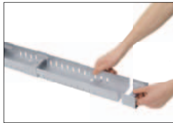
Rostaufleger für eine stabile Abdeckungsauflage positionieren und ggf. Stirnwand einsetzen
