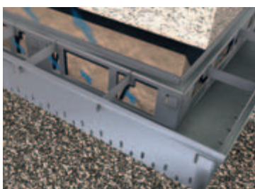
Schritt 9 Rinne einsetzen
