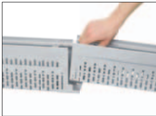
Rinnelement von oben bis zum Einrasten in den Verbinder einsetzen
