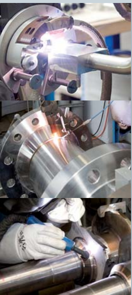
Orbitalschweissen von Spezial-Rohrverbindungen für die Lebensmittelindustrie
