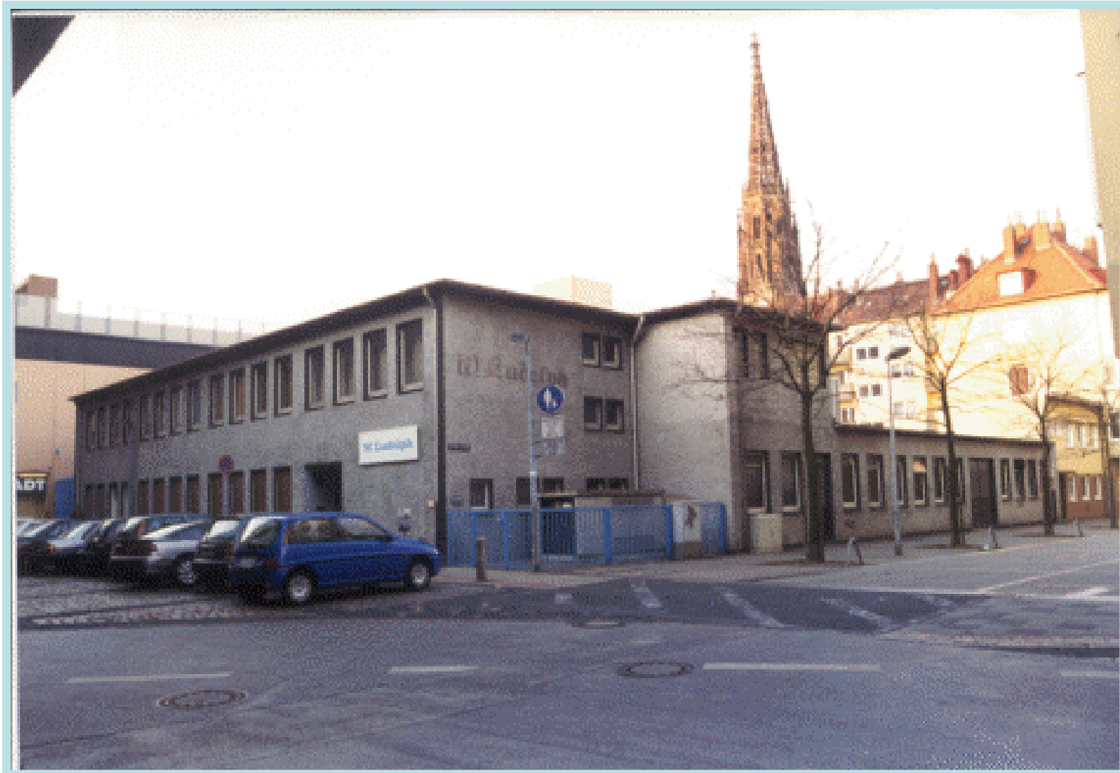
W. Ludolph Firmengebäude mit Produktionshalle von 1954 bis Oktober 2000
