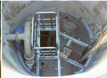
Gitterrostabdeckungen verschiedene Ausführungen in Stahl und Edelstahl
