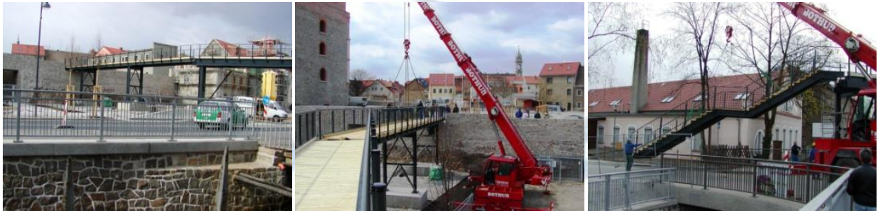
Herstellung zweier temporärer Brücken Landesgartenschau Großenhain
