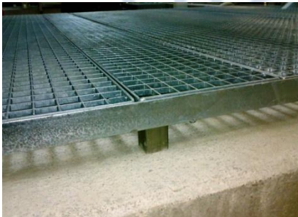
Gitterrostabdeckungen verschiedene Ausführungen in Stahl und Edelstahl
