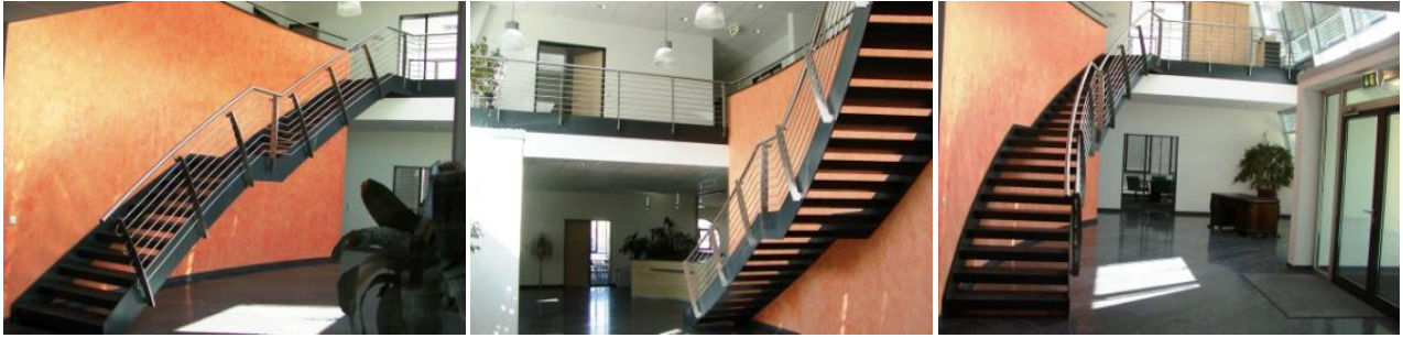
Stahltreppe mit Geländer in Edelstahl
