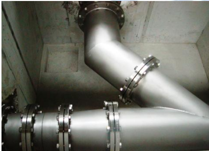
Zu- und Ablaufrohre; Saugrohre; Belüftungsrohre wahlweise in Stahl; Stahl verzinkt; Edelstahl
