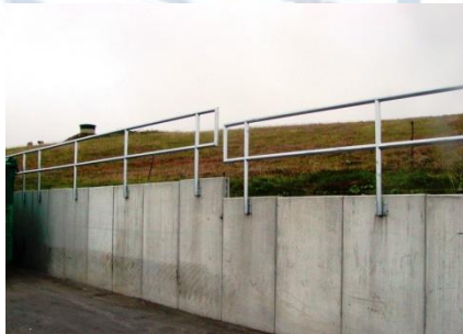
Rohrgeländer nach RiZ GEL / Rahmengestell zur Lagerung von Betonfertigteilen
