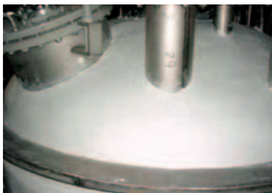
Kesselisolierung, Degussa Hüls Insulation of vessels, Degussa Hüls
