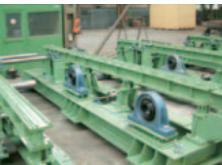
Fertigung und Montage einer Ein- und Austragmaschine Manufacture and assembly of a conveying machine
