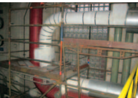
Isolierung von 520°C Heißdampfleitung, Bayer Industrial Service Insulation of a 520°C superheated steam conduit at Bayer Industrial Service
