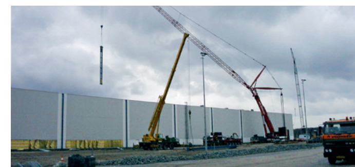
Hebereinbringung über Dach mit großem Mobilkran Lifting in the equipment through the roof using a large mobile crane
