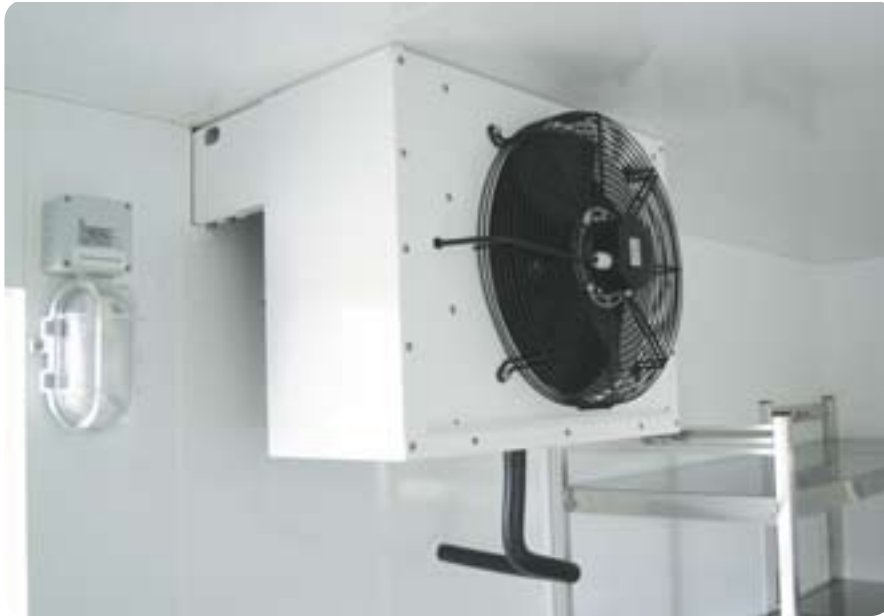
Einbausituation Huckepack-Aggregat (Verdampfer)
