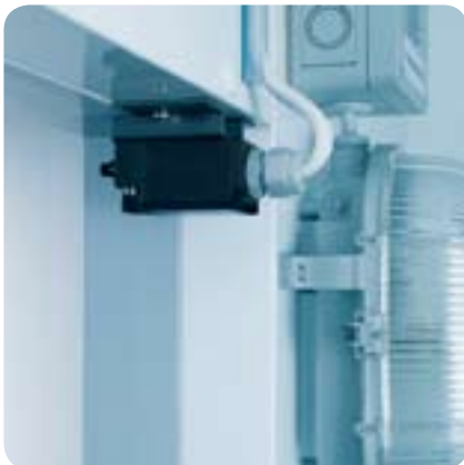
Türkontaktschalter zur automatischen Steuerung
